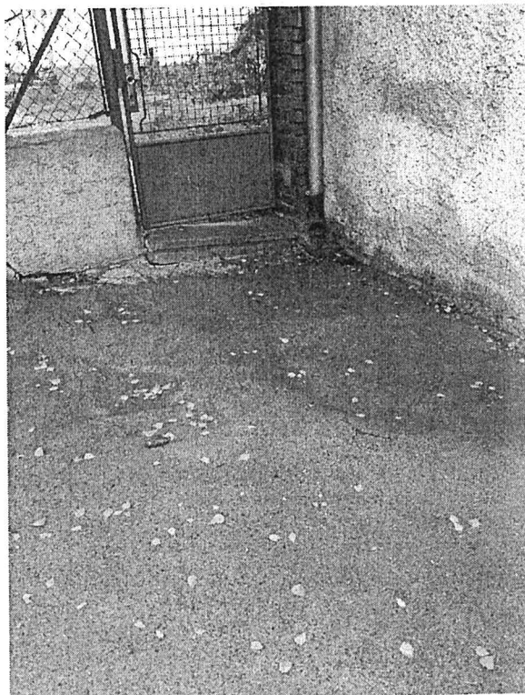
Prorůstání kořenového systému vzrostlých dřevin do komunikace
