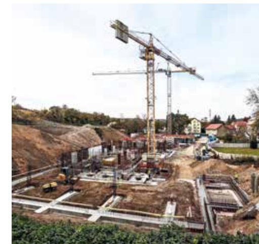
Dokončení základových konstrukcí a pokračující hrubá stavba
