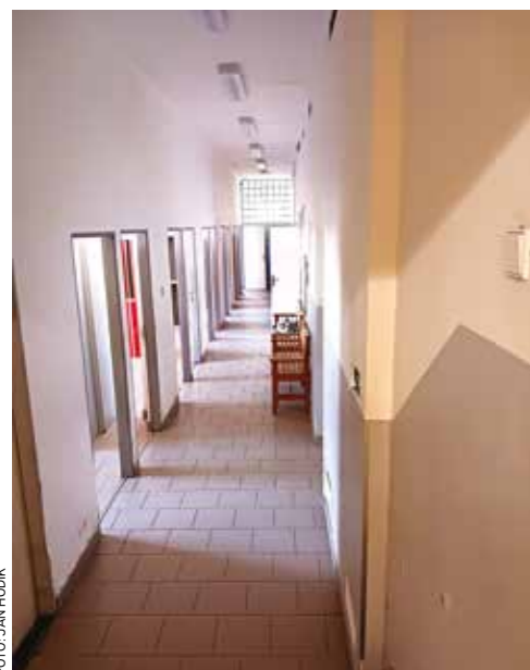
Na chodbě byla odstraněna předstěna, zřízeny nové rozvody vody a elektřiny. Elektřina je nově vedena ve žlabu u stropu, kde se plánuje instalace podhledů.
