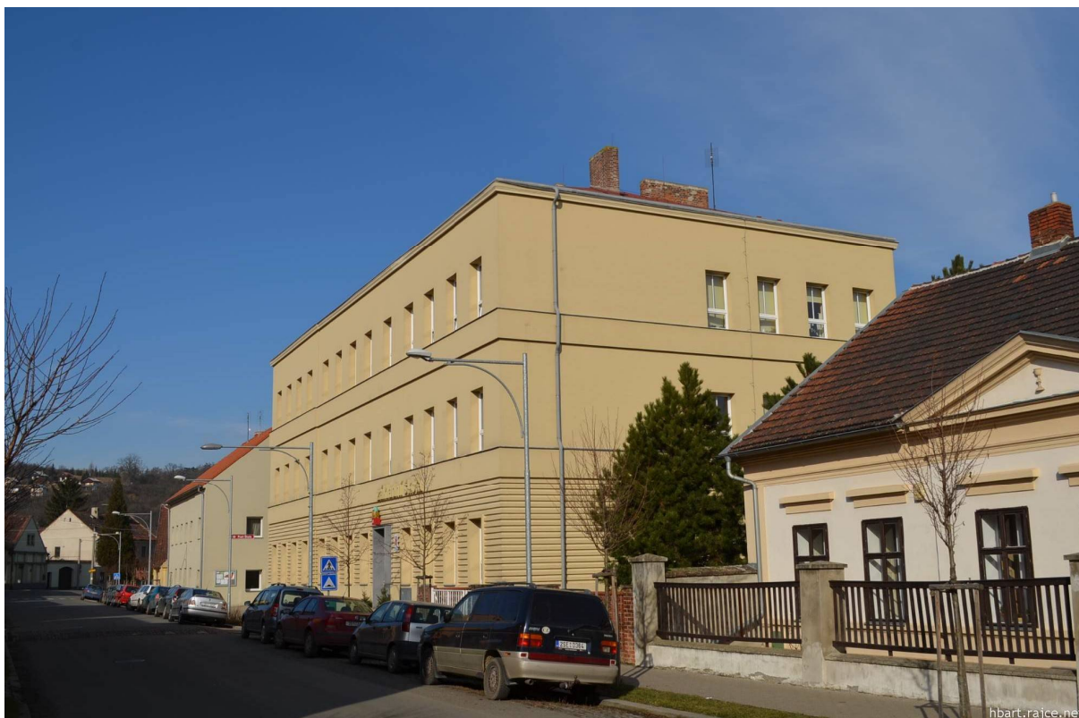
Opravená budova základní školy
