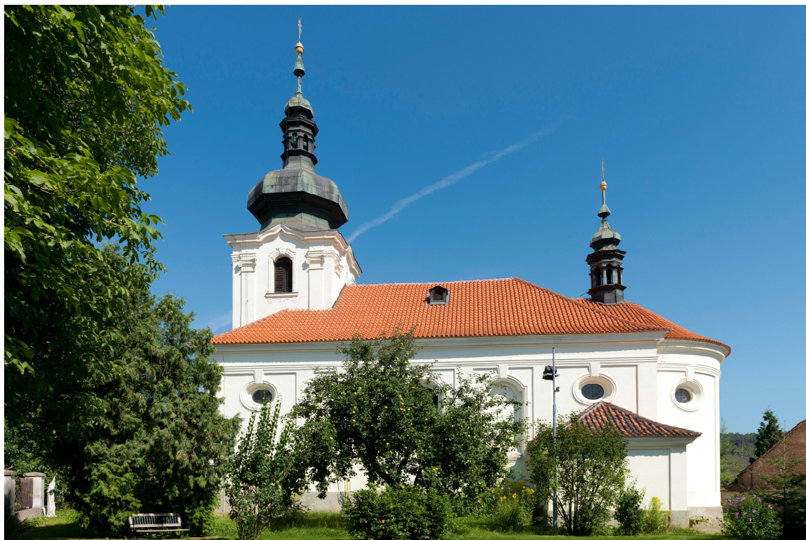
Opravený kostel sv. Bartoloměje (2014, foto Pavel Vychodil)
