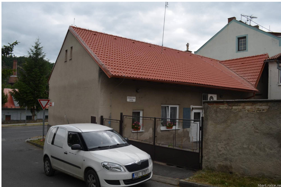
Objekt pečovatelské služby v ulici Na Radosti s novou střechou
