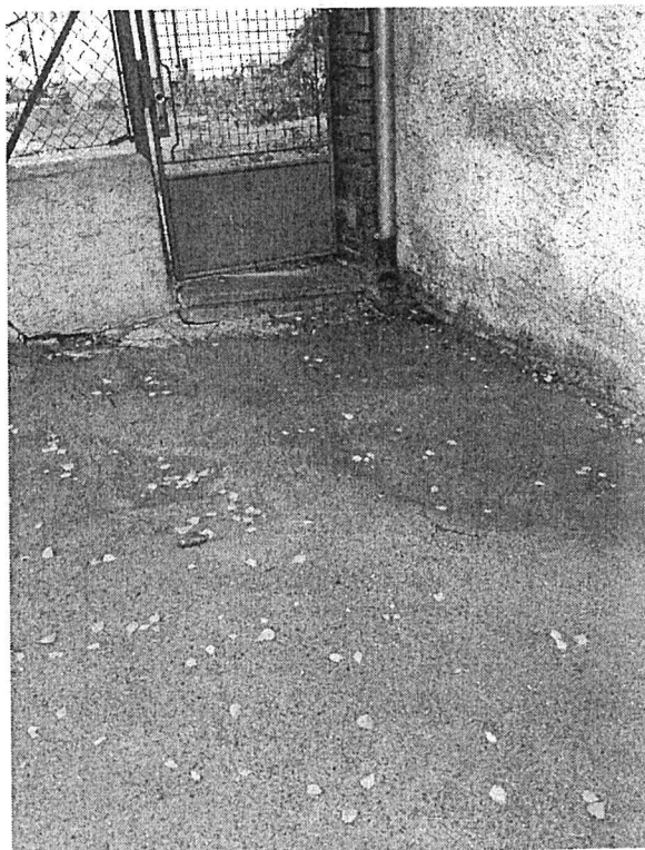
Prorůstání kořenového systému vzrostlých dřevin do komunikace
