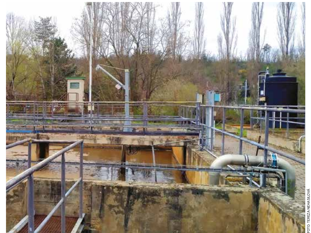
Libčická čistírna odpadních vod
