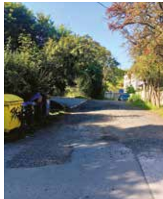
Současný stav komunikace Letecká x Pod Hliníkem
