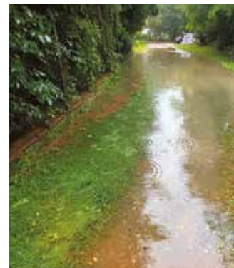
Současný stav komunikace Pod Hrádkem – při deštích je ulice těžko průchozí
