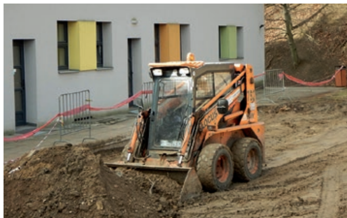
Zemní práce ve školce.
