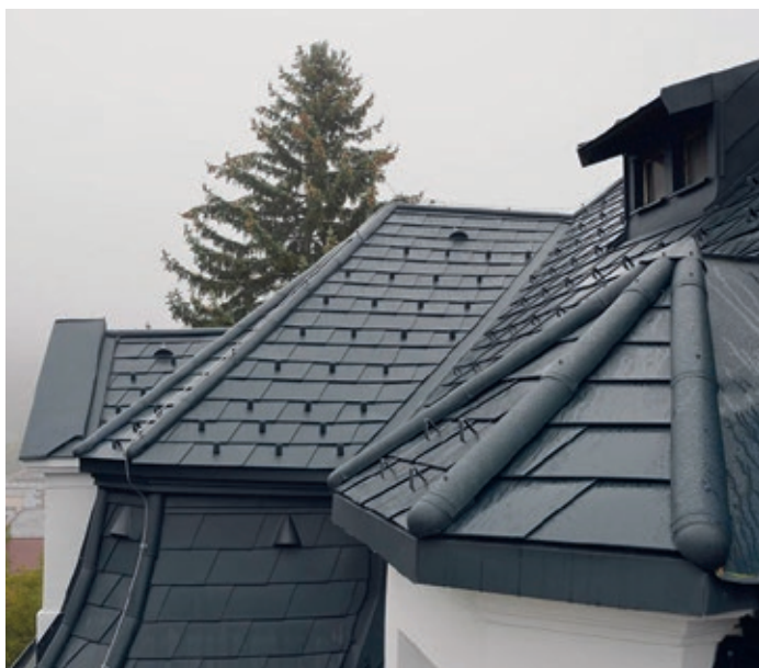
Nová střecha na budově ZUŠ.
