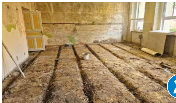
Třída 5. A po odstranění podlahy na škvárový zásep a před montáží podlahových soklových lišt.
