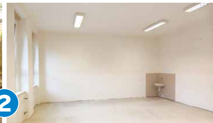
Třída 5. A po odstranění podlahy na škvárový zásep a před montáží podlahových soklových lišt.
