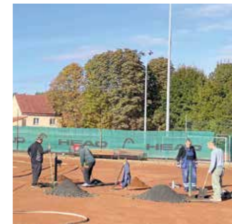
Na rekonstrukci se výrazně podílíme vlastním úsilím.
