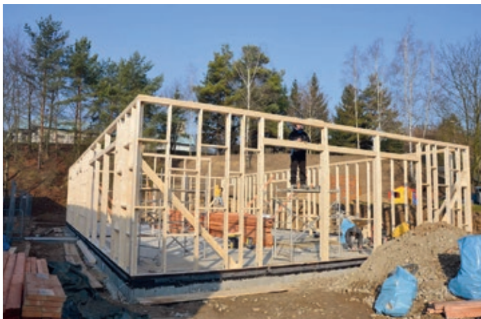
Stavba obvodových zdí nového pavilonu v MŠ.
