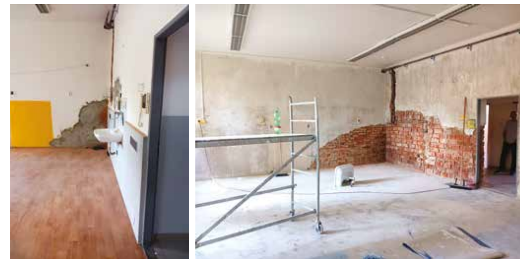
Předstěny ve třídách byly odstraněny a bylo provedeno nové napojení na rozvod vody.
