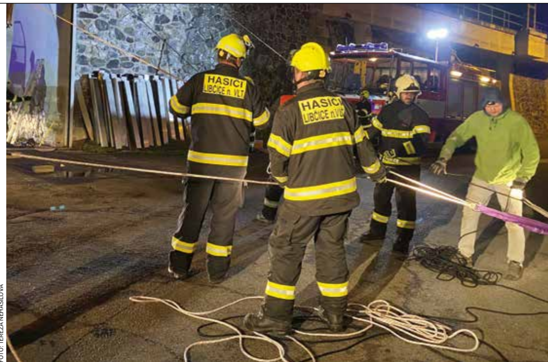
Montáž protipovodňových zábran v podjezdu Vltavské ulice v noci ze 14. na 15. září, kdy voda kulminovala.
