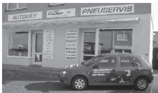
Rožtoky - Přilepská 1233 (proti benzínové pumpě)
